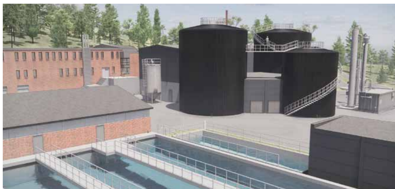
Ovan och till höger: Om- och nybyggnation av slamhantering vid Rosenholms avloppsreningsverk.
